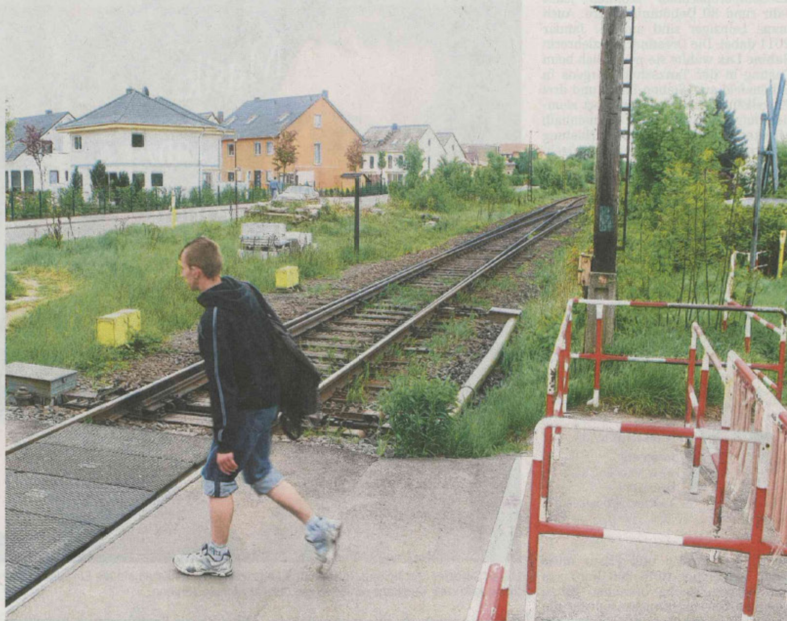
Kein Zug, vielleicht aber eine Lösung in Sicht: Der Übergang Equipagenweg ist seit Jahren in der Diskussion. Jetzt scheint die Bahn einzulenken, und prüft die von Anwohnern geforderte Tunnelvariante. Foto: André Kempner
