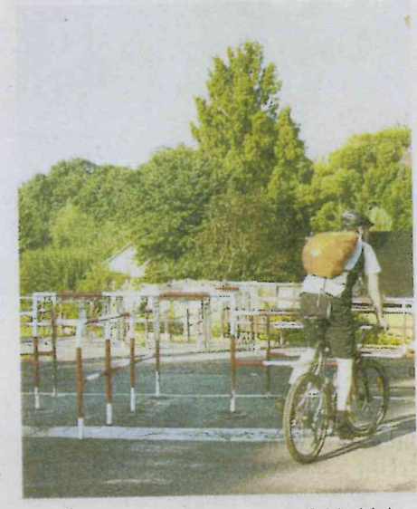
Am Übergang Equipagenweg fehlt bisher ein Schutzkonzept. Fotos: André Kempner
