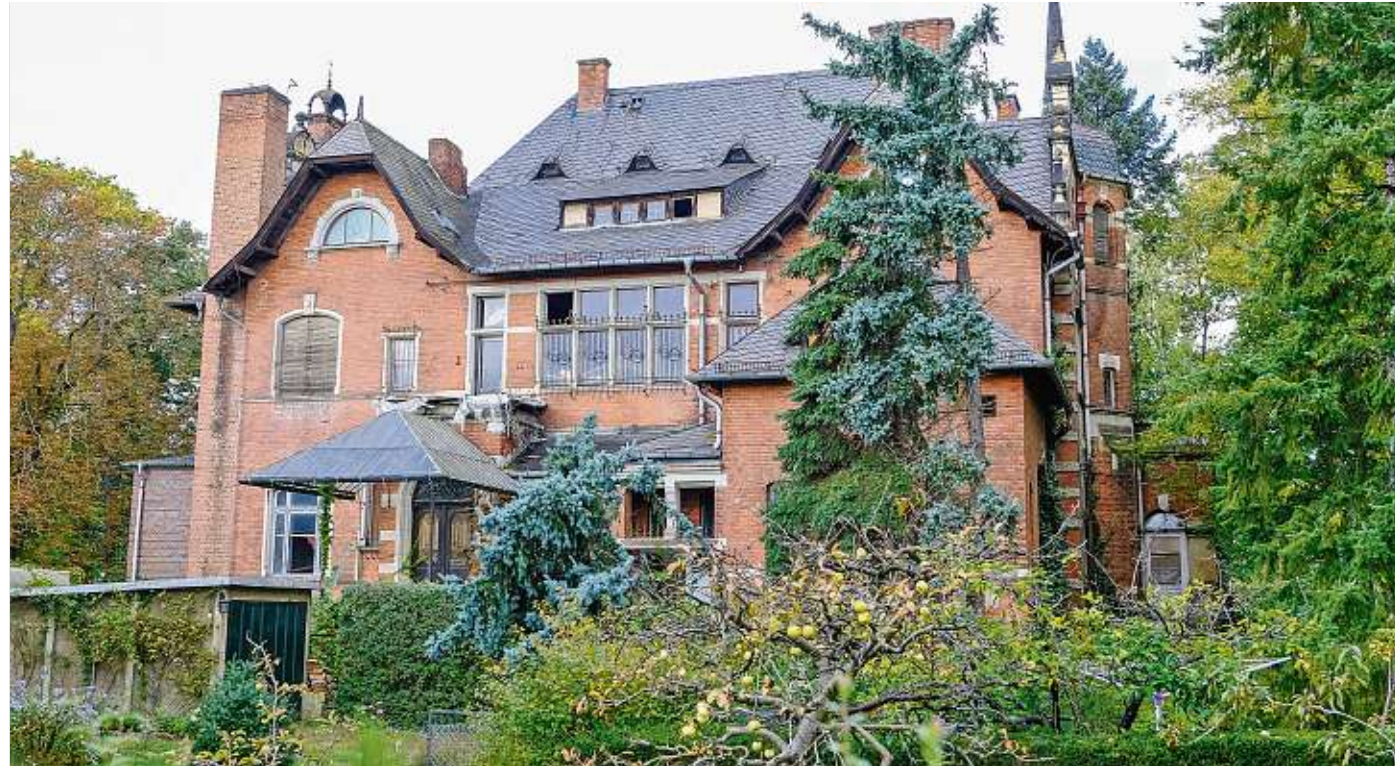
Seit Mitte der 1990er-Jahre steht die Villa Kolbe an der Zinzendorfstraße leer und verfällt.
